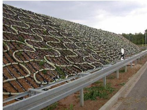
Geotextilien am Chemnitzer Südverbund Quelle: STFI
