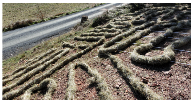
Im Projekt ProGeo entwickelte Geotextilien aus nachwachsenden Rohstoffen sorgen für nachhaltigen Erosionsschutz
