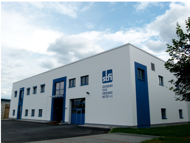
Das neu errichtete „Zentrum für Textilien Leichtbau“ ergänzt zukünftig die Kompetenzen des STFI in den Bereichen des Recyclings von Hochleistungswerkstoffen
