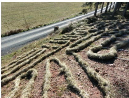
Ausgelegte Stränge und Geogitter für Begrünung
