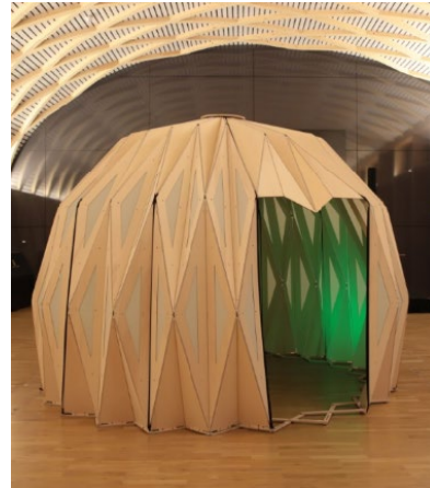
Holz-Textil-Faltwerk, Foto: IHD Dresden
