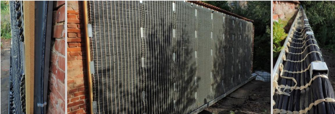
Abb. 2: Mehrschichtiger Aufbau des Fassadenvorhangsystems mit Dämmschicht und textilem Vegetationsträger; am oberen Ende in eine frostsichere Bewässerungsrinne eingelegt
