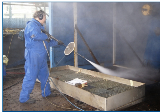
Arbeiten mit einer handgeführten Hochdruck-Wasserstrahlanze
