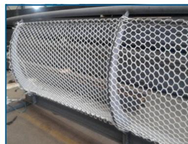
Brückengeländerfüllung mit gewirkten Netzen
