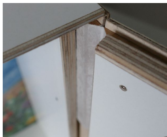
Abb.: Anwendung des Vliesstoff-WPC-Verbundes beim Scharnier einer Holzvitrine.
