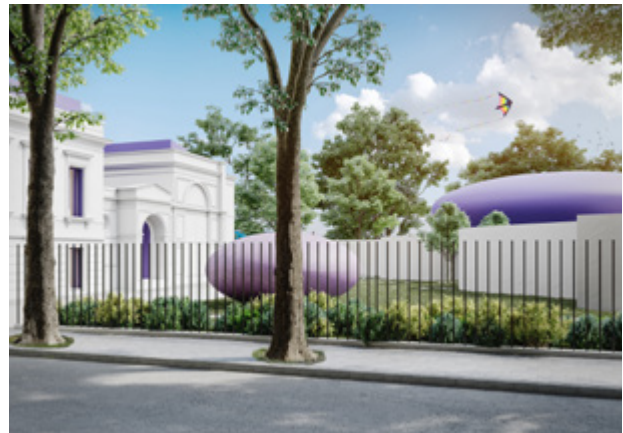
Abbildung 9: Der fünf Meter große Demonstrator (Vordergrund) an der Bautzener Straße in Dresden zeigt anschaulich die dünnwandige Betonschalenbauweise. Bild: Gerd Priebe, GPAC – Dresden
