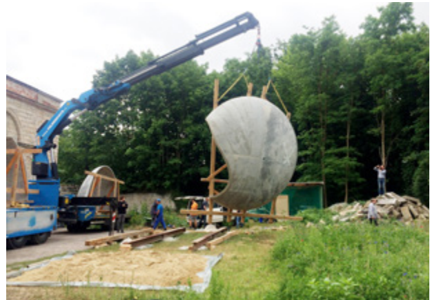
Abbildung 6: Die Errichtung des Demonstrators in Dresden an der Bautzner Straße. Foto: Gerd Priebe, GPAC – Dresden
