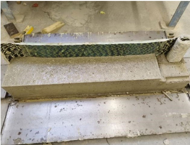
Abbildung 4: Textiles Halbzeug auf Trägermaterial gestickt (links oben), Einbinden des textilen Halbzeugs in Gießsilikon (rechts oben), Einbau Fugendichtung in Bodenplatte (links unten), Betonage der aufgehenden Wand (rechts unten), Quelle: Stefan Käseberg
